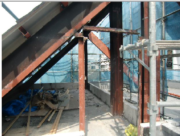
※4階 鉄骨部分だけを再利用改装前状態
